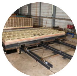
Rénovation châssis wagon
